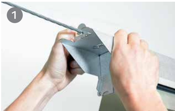
Armaturet monteres på wiren og sikres med et integreret beslag.
