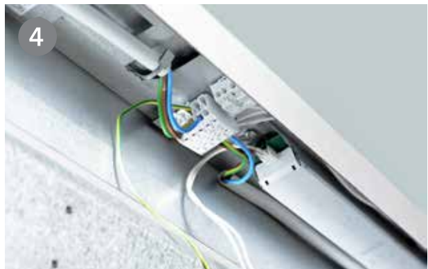
Ledningen sluttet til en 5-polet klemme med gennemfortrådning.
