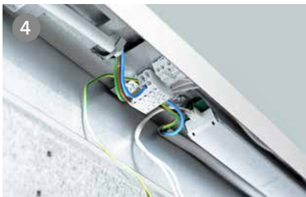
Kabeln ansluts i en överkopplingsbar 5-polig plint.
