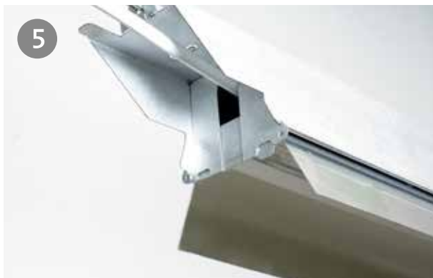
Fäll ihop armaturen och installationen är klar.
