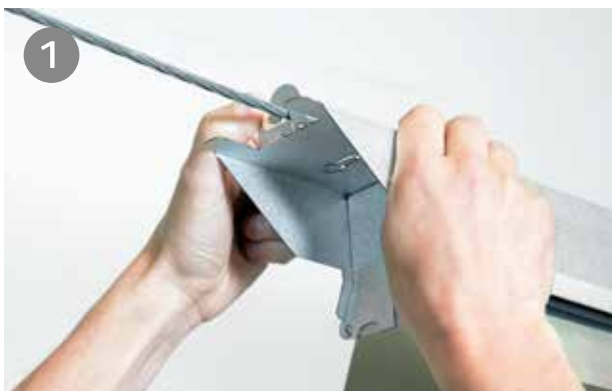
Armaturen monteras på linan och säkras med ett integrerat fäste.
