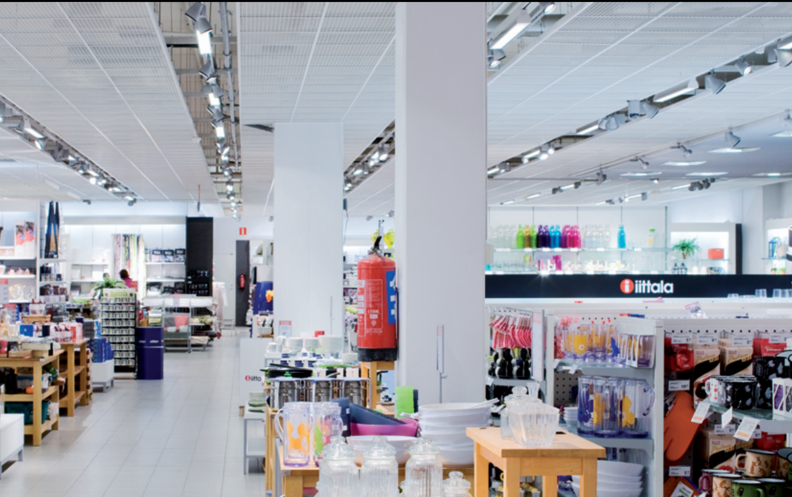
En hållbar belysningsinstallation med närvarosensorer.
