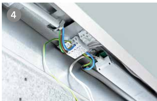
4 Johto liitetään läpijohtettavaan 5-napaiseen kytkentärimaan.
