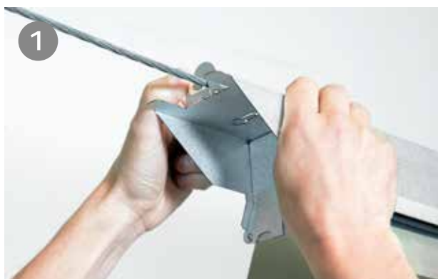
1 Valaisin asennetaan vaijeriin ja lukitaan integroidulla kiinnikkeellä.
