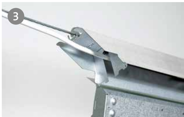
3 Johto sijoitetaan ulkopäädyn loveen ja kiinnitetään johdonpitimellä.
