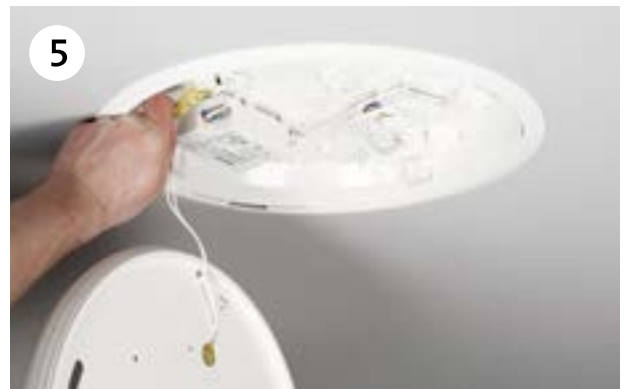
Kiinnitä turvavaijeri ja kytke pikaliitin. Asenna kupu runkoon bajonettikiinnityksen avulla.
