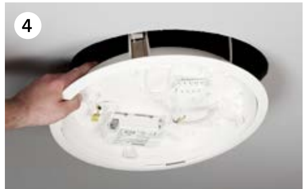
Pujota johto valaisimeen ja vapauta kolme lukitusjousta. Valaisin asennetaan upotusaukkoon.
