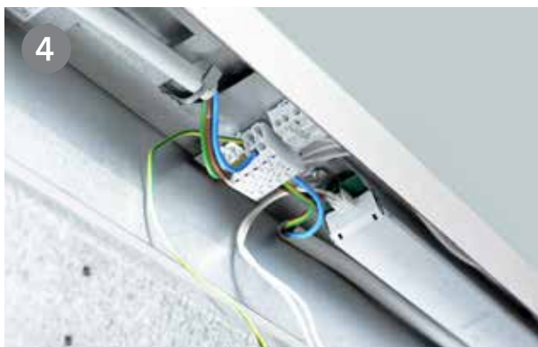
Kabeln ansluts i en överkopplingsbar 5-polig plint.
