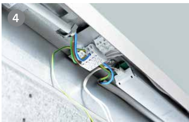
Johto liitetään läpijohtotettavaan 5-napaiseen kytkentärimaan.
