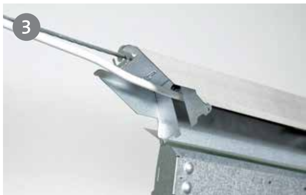
Johto sijoitetaan ulkopäädyn loveen ja kiinnitetään johdonpitimellä.
