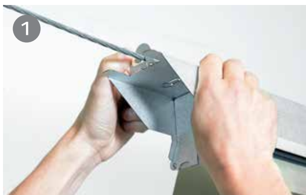
Valaisin asennetaan vaijeriin ja lukitaan integroidulla kiinnikkeellä.
